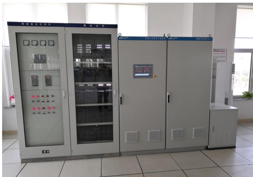
絮凝沉淀池 PLC 主站
